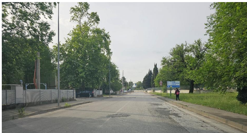
Punto E8: Via Timavo (tra nodo 2 e 3) verso l'impianto
