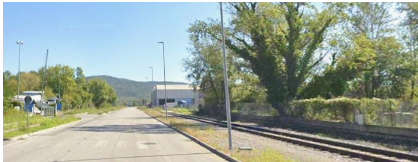
Punto E10: Via Timavo (tra nodo 3 e 4) verso l'impianto
