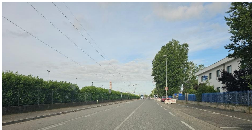
Punto E6: Via terza armata (seconda parte) verso l'impianto
